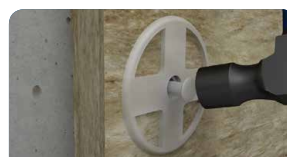
5. Use um martelo para introduzir o prego em poliamida no interior da bucha
