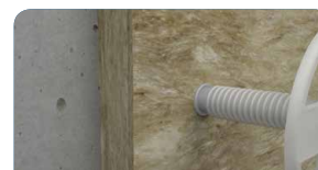
3. Insira a bucha através do painel a fixar
