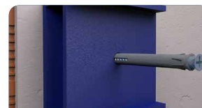
3. Insira a bucha no furo através do objecto
